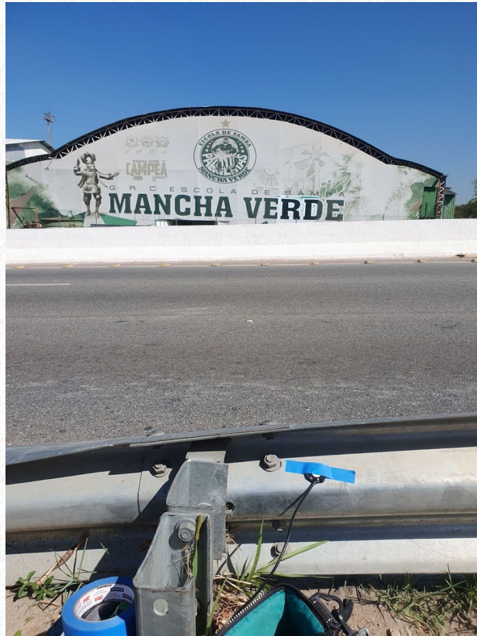
Figura 2 – Local da gravação, destaque para o sensor piezoelétrico fixado por fita azul na grade metálica da ponte Júlio Mesquita Neto em São Paulo, SP.
