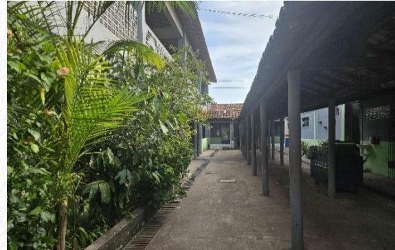
Figura 5 - Corredor de acesso às salas
